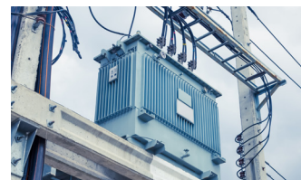
Trasformatori di potenza
