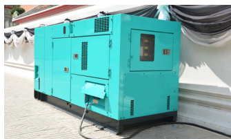
Generatori a batteria
